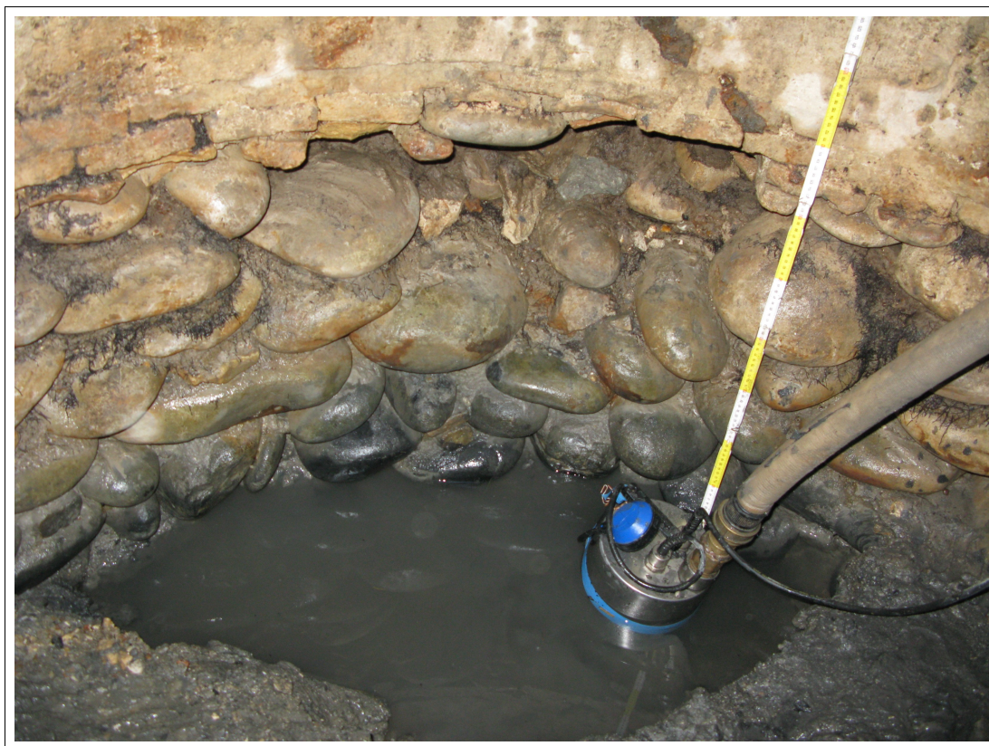
Fotografia 5: l'ultima fase dello scavo
