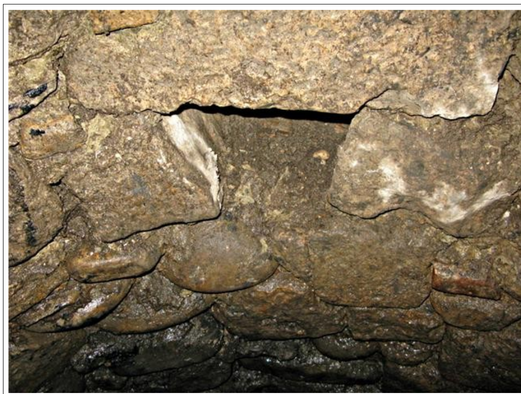
Fotografia 6: una delle aperture per l'alimentazione del pozzo
