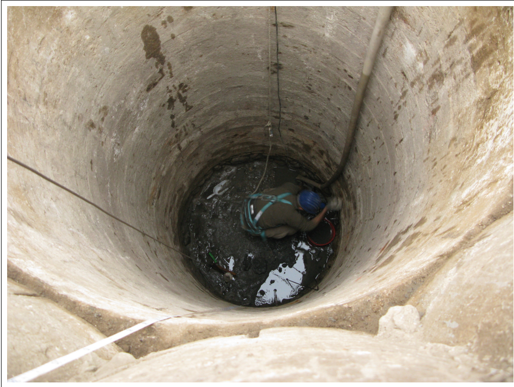
Fotografia 3: lo scavo del pozzo a livello dell'acquifero
