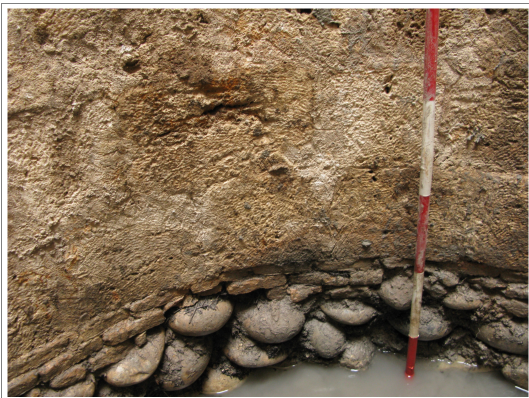
Fotografia 4: la struttura in ciottoli in corrispondenza della falda con i corsi di
